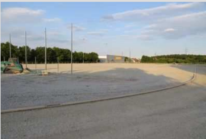
Juni '14: die neue Anlage nimmt langsam Formen an. Die Schotter-schicht liegt.
