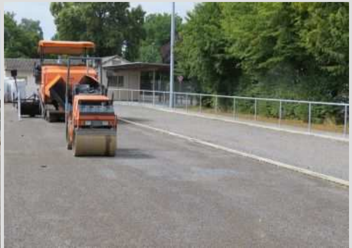
Auch das neu installierte Bandengerüst steht bereits, Knochensteine dahinter sind verlegt.
