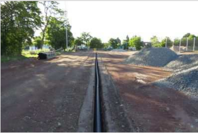
Für das Wassersystem wurden unzählige Meter an Rohren verlegt
