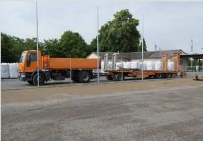
Juli '14: schweres Gerät und jede Menge Material stehen für den nächsten Arbeitsschritt bereit
