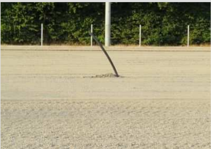
Wo vor kurzem noch ein Rohr für das Sprengersystem war, ist jetzt...
